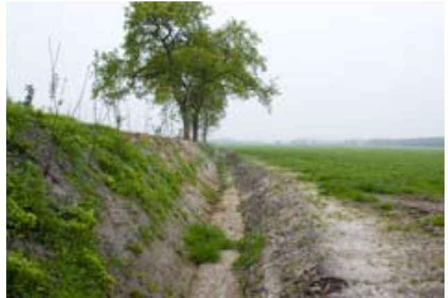
Aan beide kanten van de wal is een greppel gegraven.
