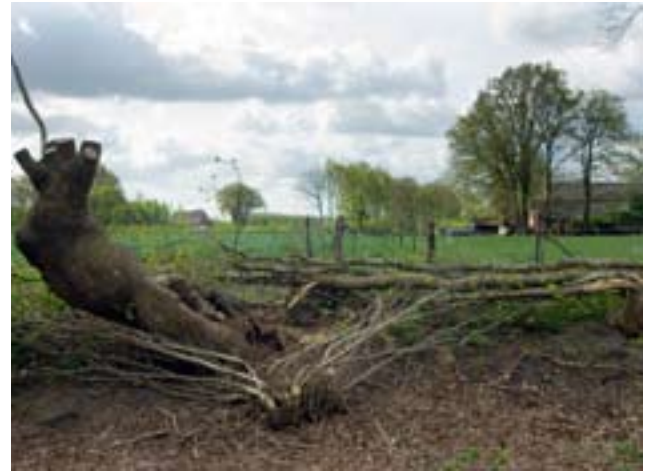
Het oude vlechtspoor op de landweer na onderhoud, met nieuwe vlechtsporen.
